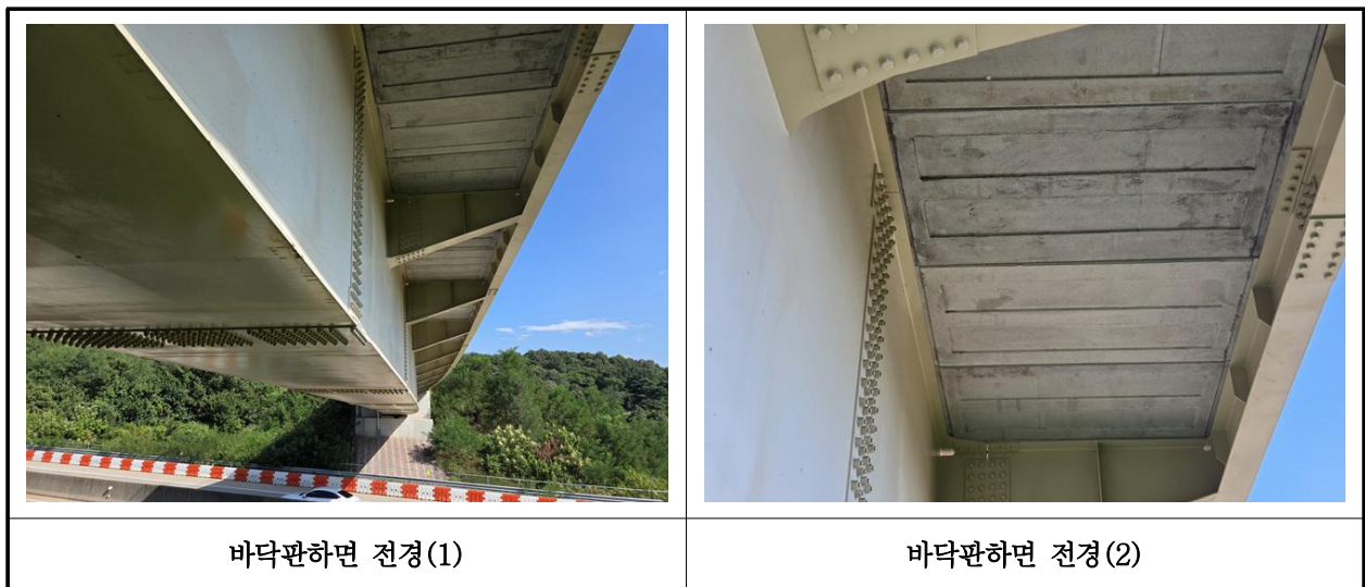
【사진 28.3.2】 바닥판하면 전경
