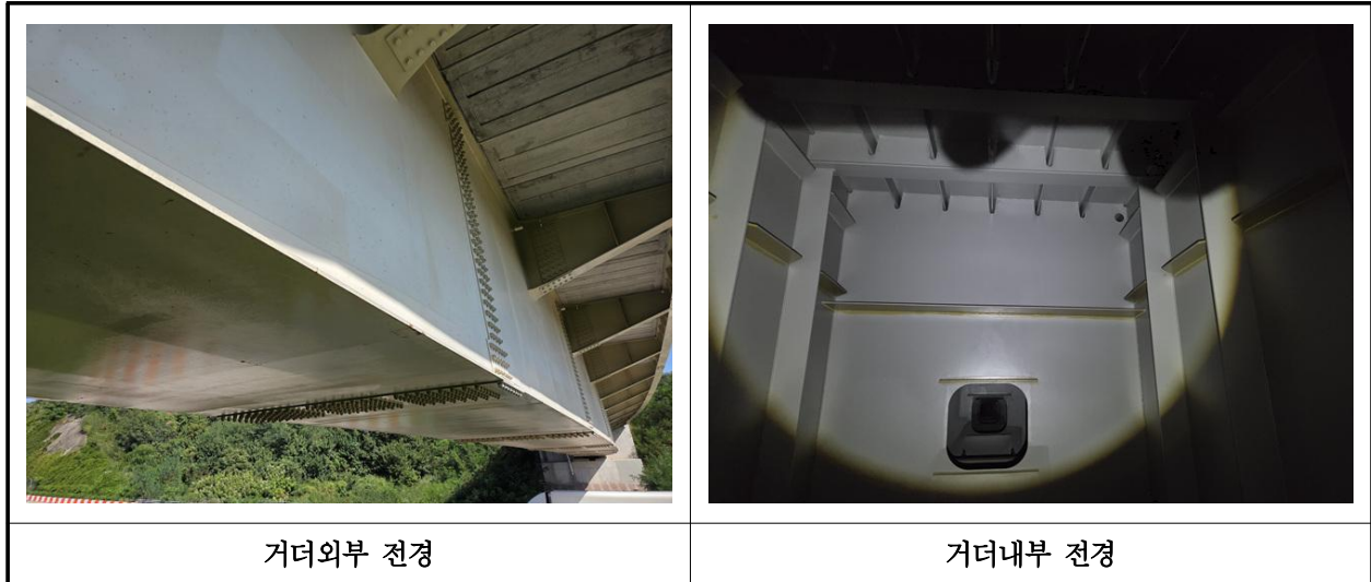
【사진 28.3.4】 거더 전경
