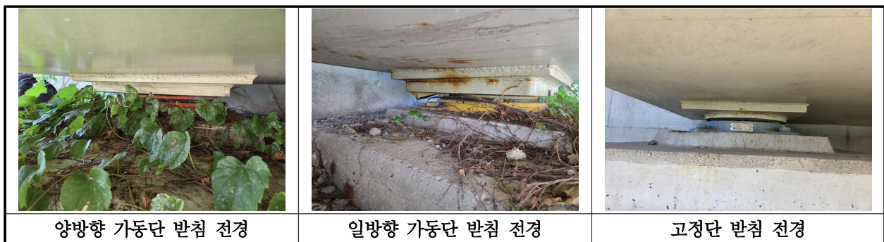
【사진 28.3.11】 교량받침 전경
