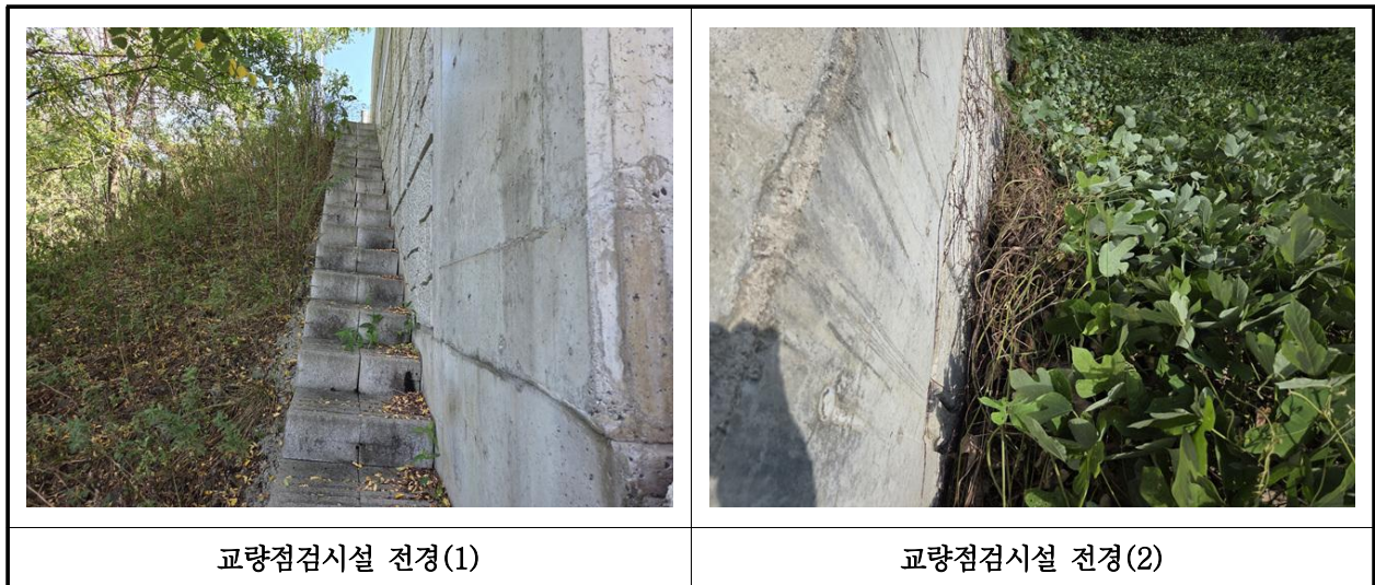
【사진 28.3.23】 교량 점검시설 전경
