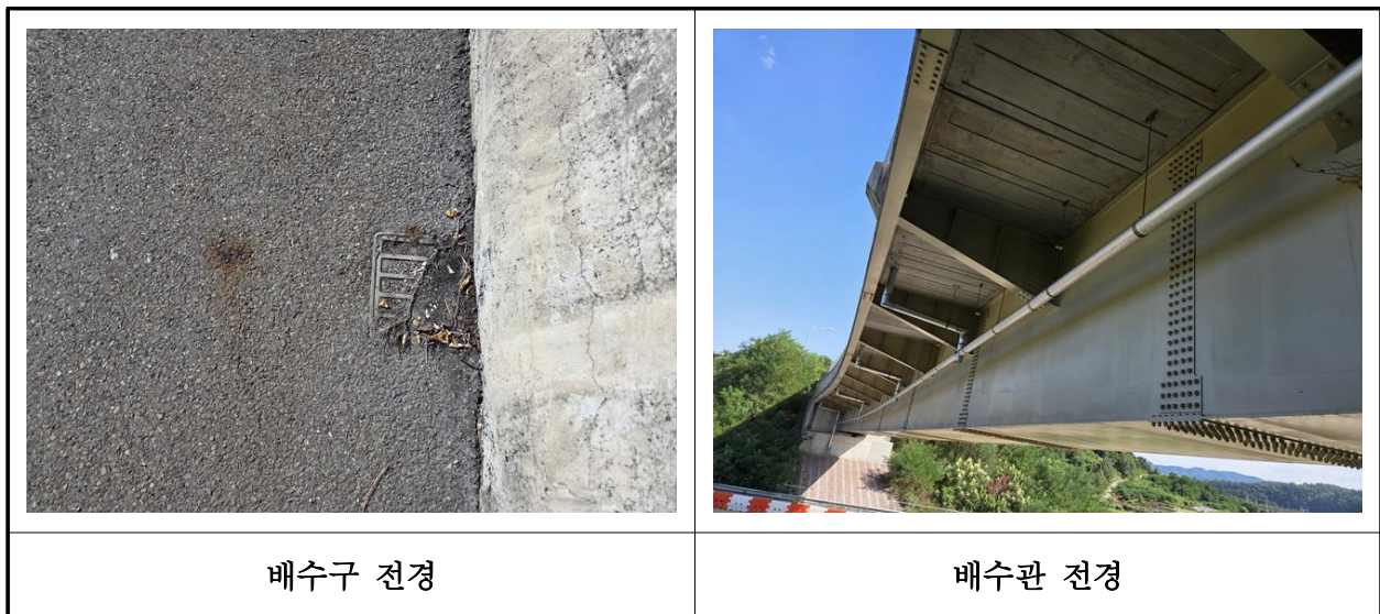
【사진 28.3.19】 배수시설 전경
