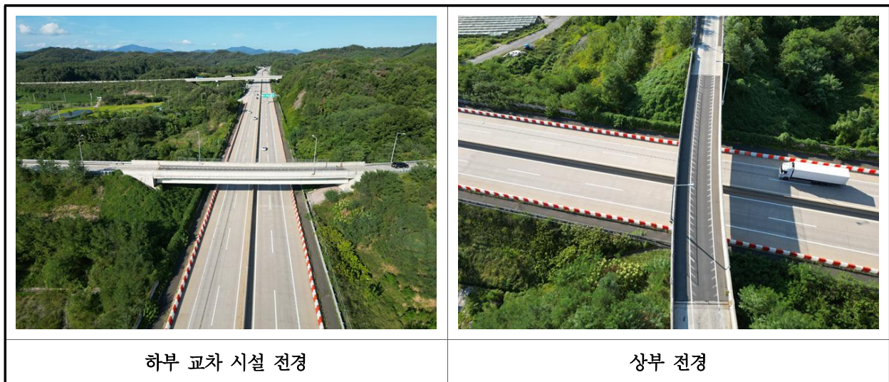
【사진 28.2.1】 부재 현장측정 전경
