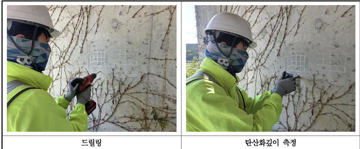
【사진 28.4.3】 탄산화 깊이 측정 현장사진
