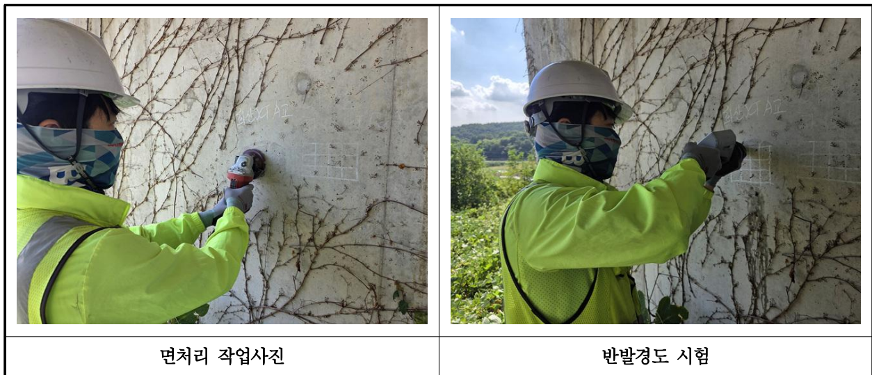
【사진 28.4.2】 반발경도시험 현장사진
