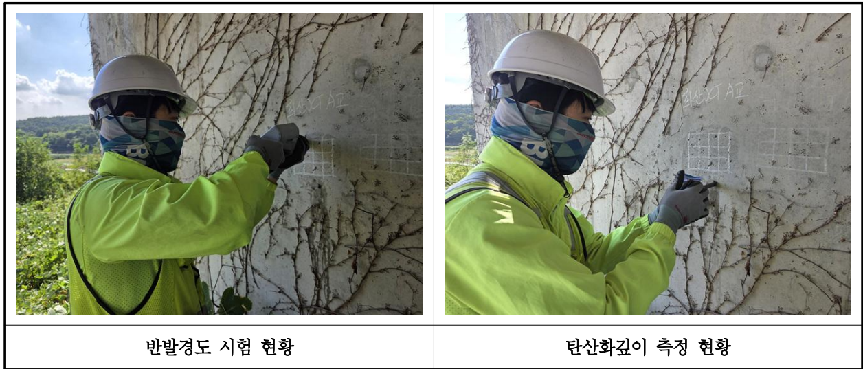
【사진 28.4.1】 콘크리트 내구성조사 현황
